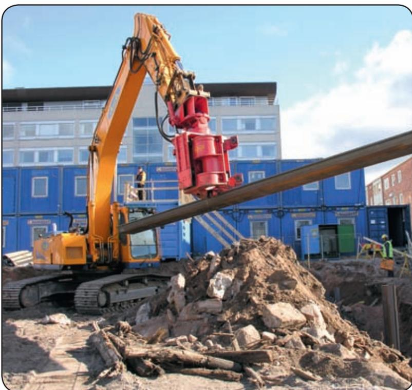
Шпунтовое ограждение стенок котлована. Гусеничный экскаватор VOLVO EC-240LC с вибропогружателем SPH-80 и дополнительной гидравлической станцией.
