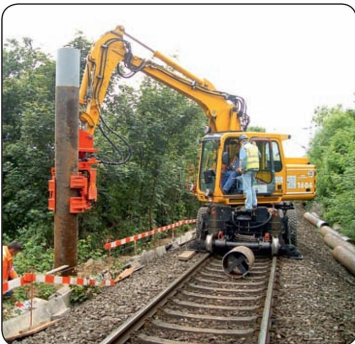
Погружение стальных труб, используемых в качестве основания для шумозащитных ограждений и опор контактной сети. SP-40W и Terex 1604 KZW.
