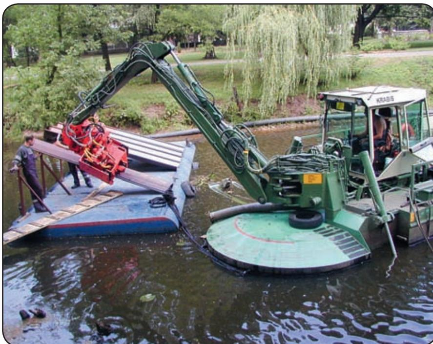
Расчистка канала и берегоукрепления с использованием земснаряда Watermaster с вибропогружателем SP30.
