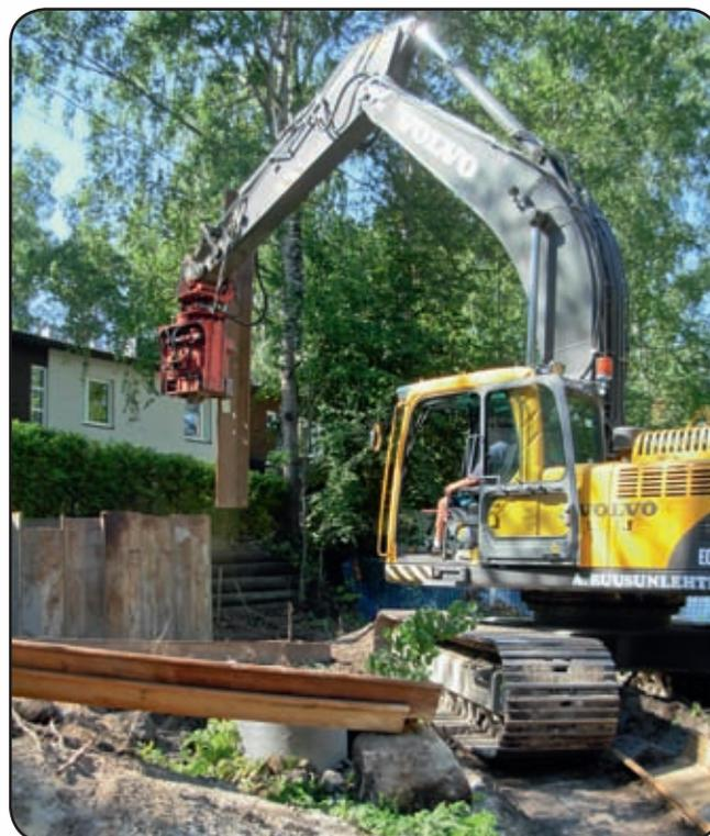
Подпорная стенка для выравнивания наклонных участков. Volvo EC290B LC и SP60F.
